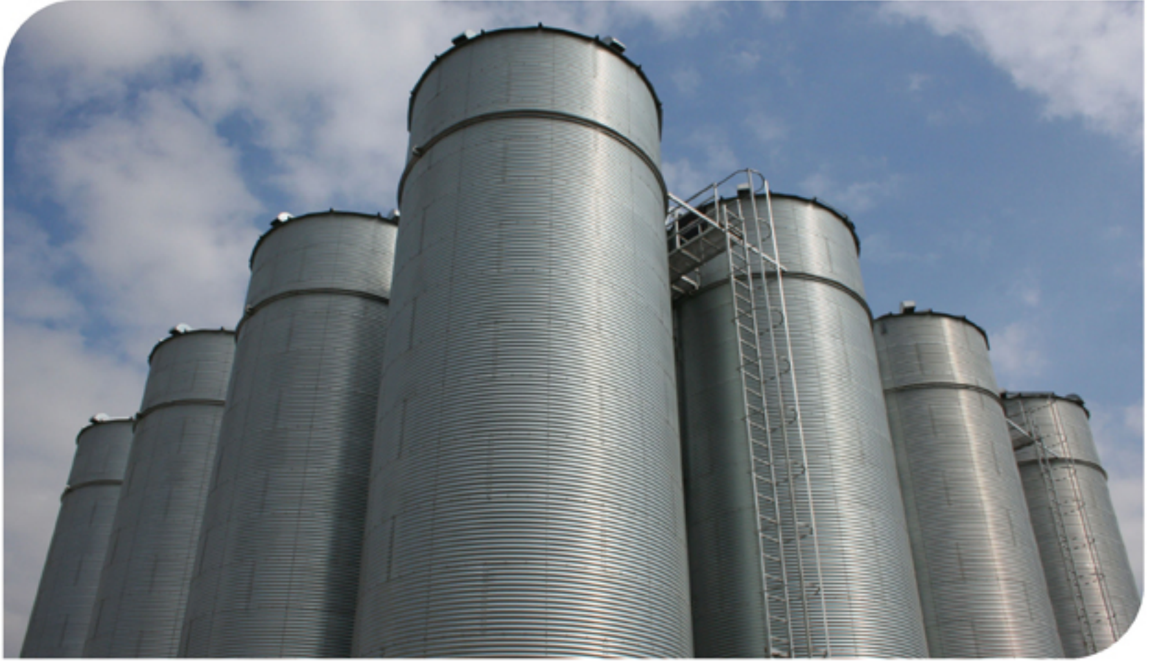
Filli Boya Silo Yürüme Yolları
